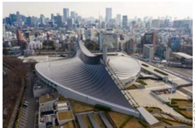
Yoyogi National Gymnasium
